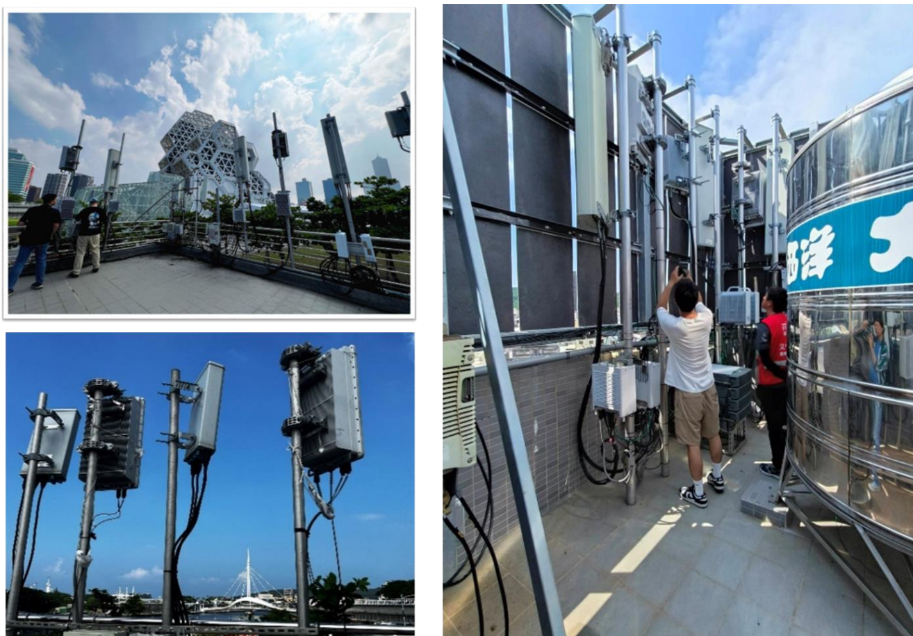
圖 36 5G 基地臺建設現場
