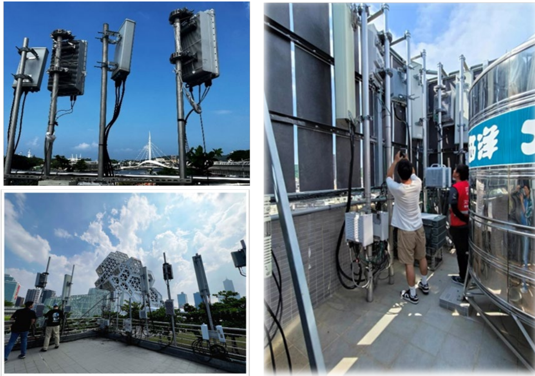
圖 11 5G 基地臺建設現場
