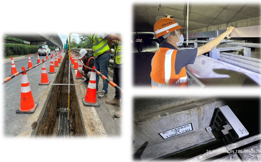
圖 14 光纜通道建設現場
