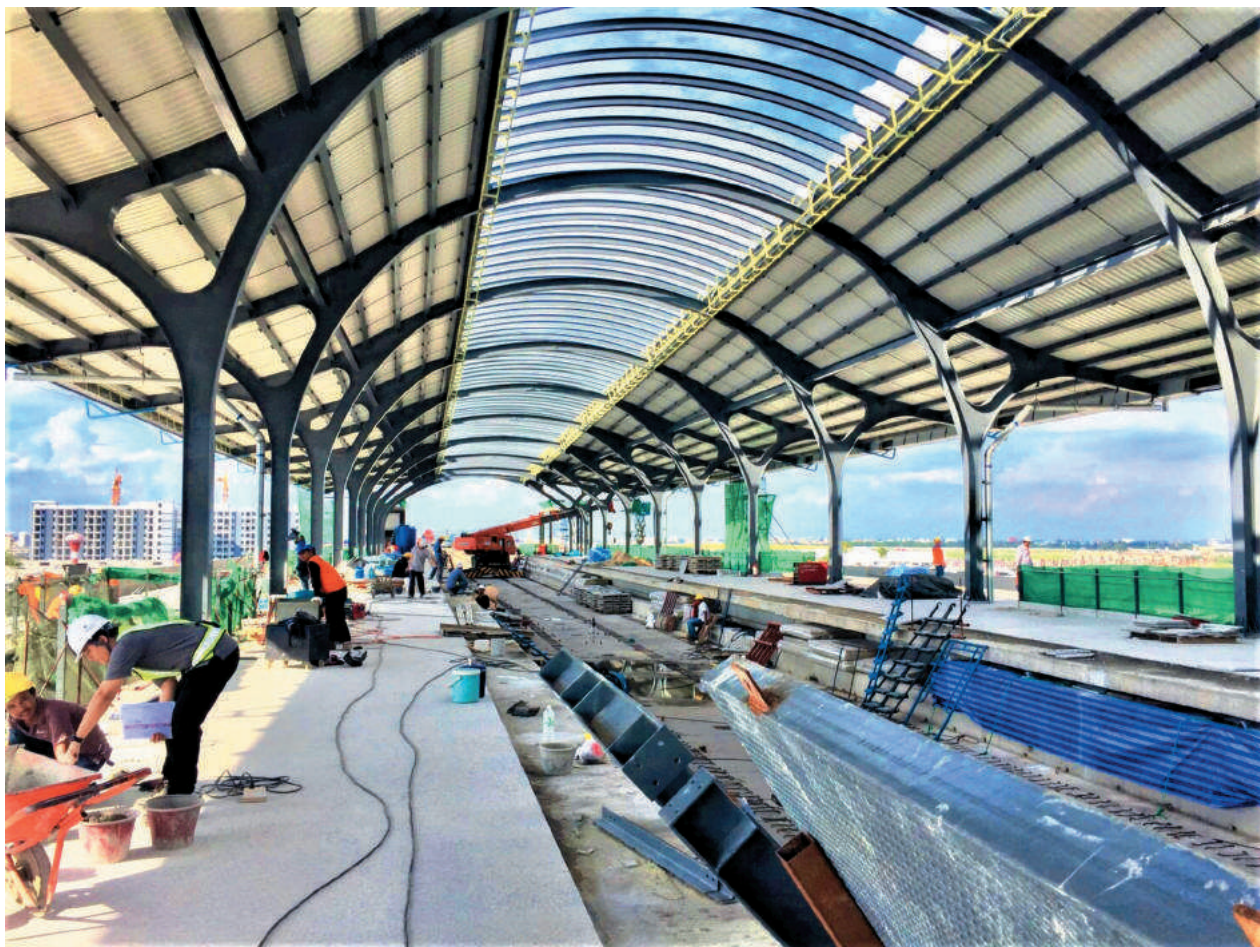
▲ 泰國鐵路紅線施工狀況 SRT Red Line in Thailand
